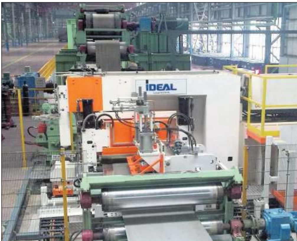
Eine der Lippstädter Maschinen im asiatischen Werk: 18 Meter lang, acht Meter breit und fünf Meter hoch ist diese Laser-Schweißmaschine – vor und hinter ihr laufen bereits die Stahlbleche.
